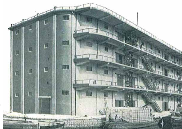
空缶の積み出し風景。舟に荷が積み込まれているのがみえる（提供・北海製罐）
